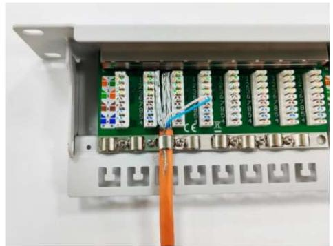
7. Raccorder les fils en commençant par la borne 8 avec l'outil de pose LSA.
