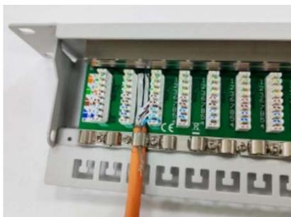
8. Fixer les serre-câbles pour soulager la traction et enclencher le capot de protection.
